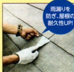
●タスペーサーの設置 (スレート屋根)
