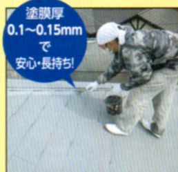
●遮熱屋根塗装
